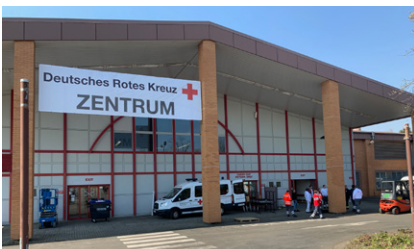
Ehemalige Commissary Bitburg als Rotkreuz-Corona-Zentrum umgewandelt.
